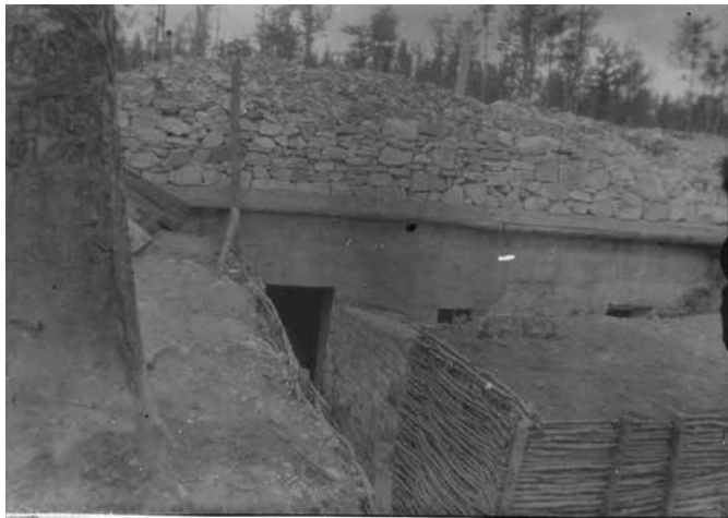
Neuer Unterstand im Bereitschaftserdwerk für die Zugführer
