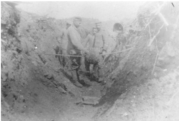
Soldaten die „Spanische Reiter“ herstellen im Verbindungsgraben der Sappe 2
