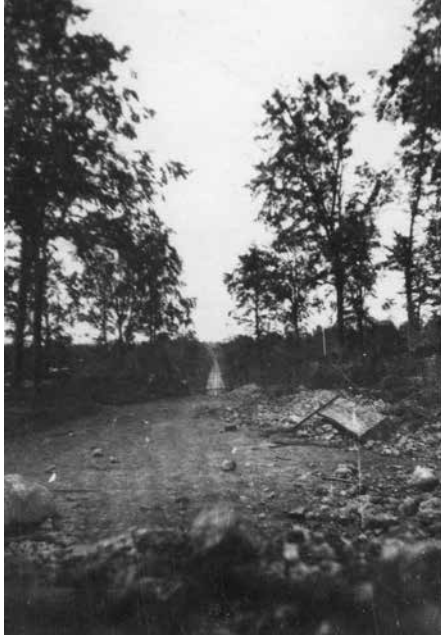
Granateinschläge auf der Straße zum Erdwerk
