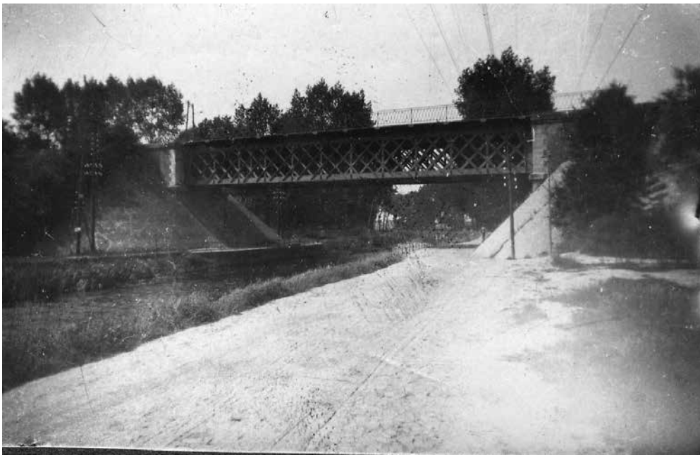
Eisenbahnbrücke über den Kanal bei Souchez
